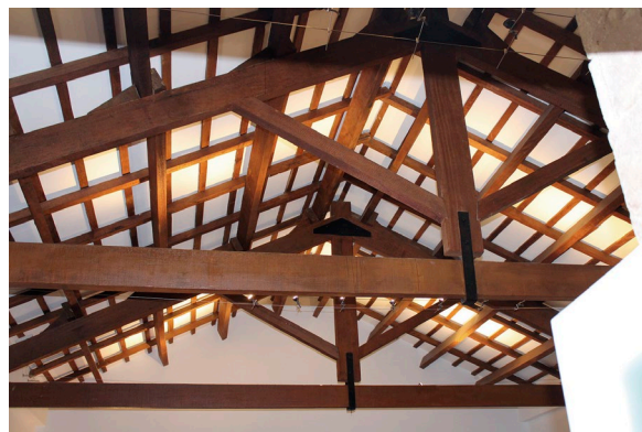
Fig. 21: Les bigues s'han construït amb fusta d'iroko per mantindre l'esperit original, [Fotografia], 2021, Arxiu del CEL.
