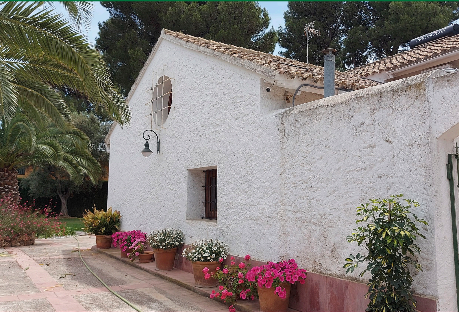
Fig. 1: Aspecte actual de la masia, [Fotografia], s.d., Arxiu del CEL.
