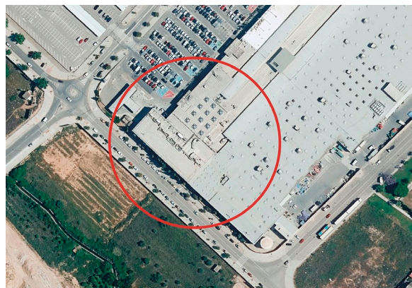
Fig. 3: L'actual Centre Comercial «El Osito» sobre els terrenys on se situava la Masia de Blanes, de la qual no en queda cap rastre.
