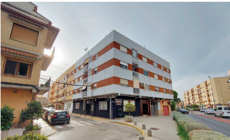
Fig. 17: Edifici construït al lloc on se situava el cine Palacio, cantonera al carrer Mare de Déu del Rosari i Avinguda Camp de Túria [Fotografia], 2021, Arxiu del CEL.
