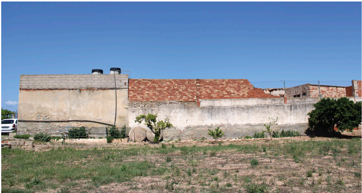
Fig. 10: Blocs de ciment sobre la pedra original, per a elevar els murs [Fotografia], 2021, Arxiu del CEL.
