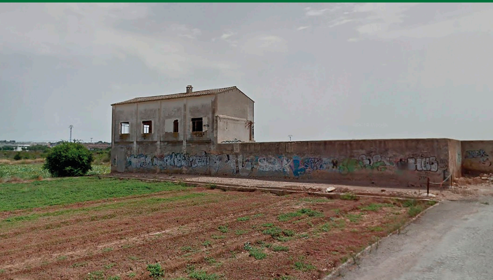
Fig. 1: Aspecte actual de la masia [Fotografia], 2021, Arxiu del CEL.
