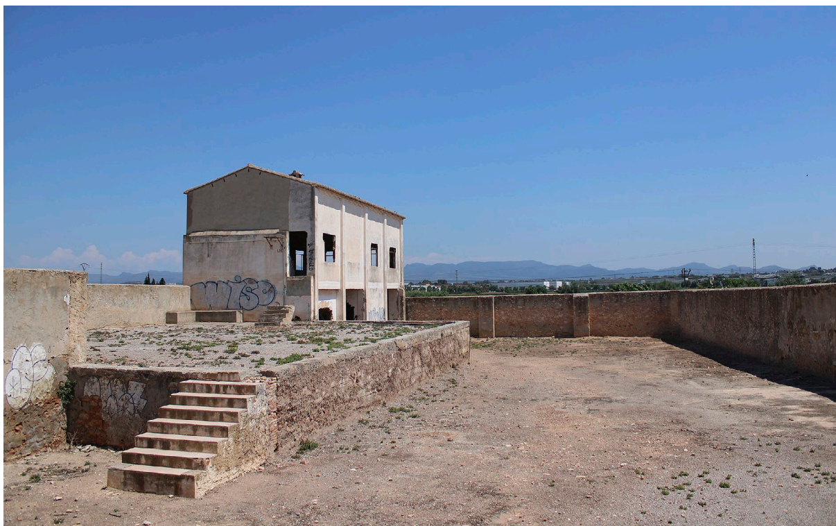
Fig. 12: Superfície sobreelevada amb escala i restes de taulells [Fotografia], 2021, Arxiu del CEL.
