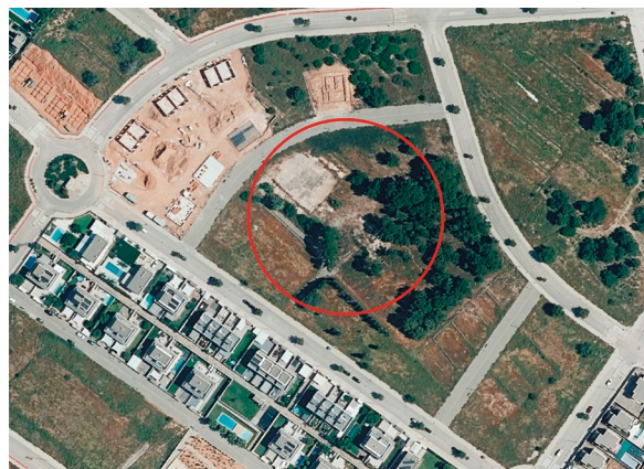
Fig. 4: La masia, després de la demolició completa.
