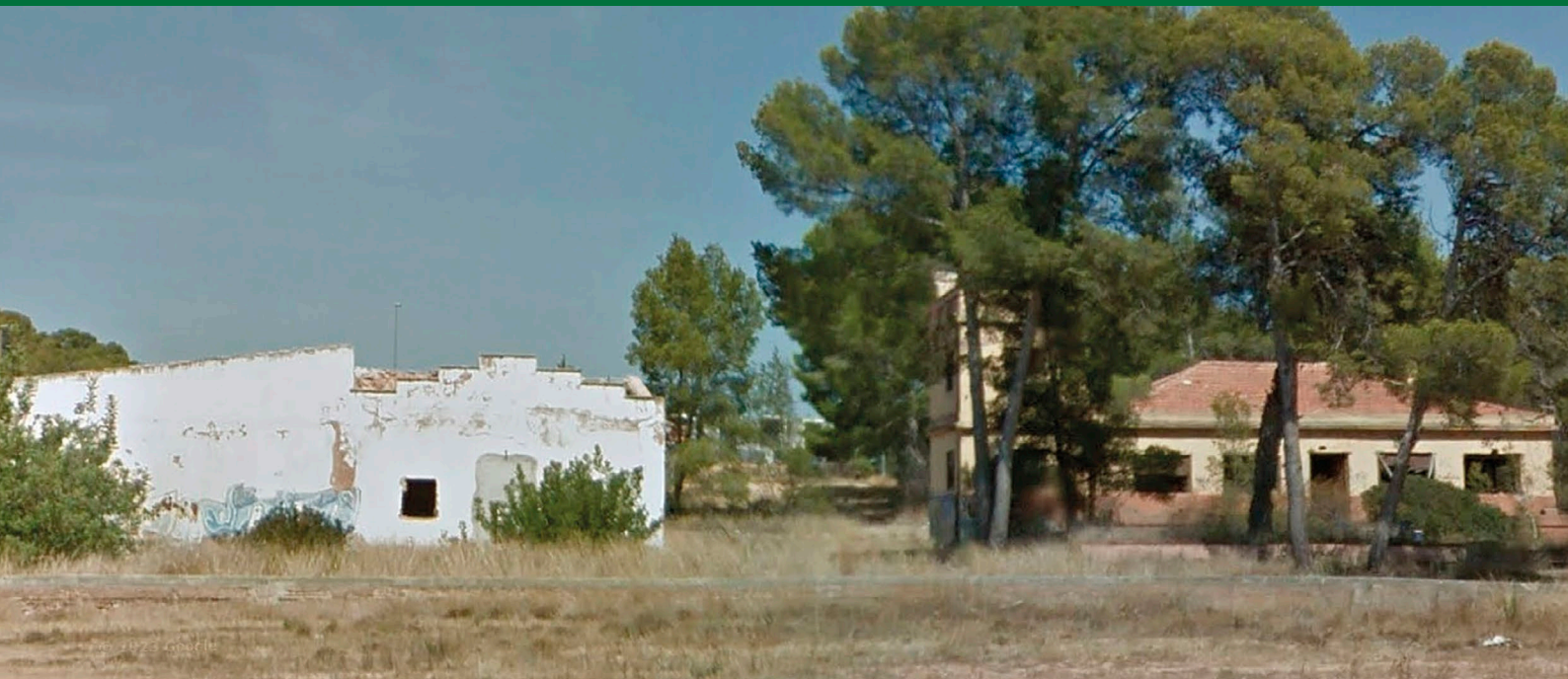
Fig. 1: Aspecte de la masia original.
