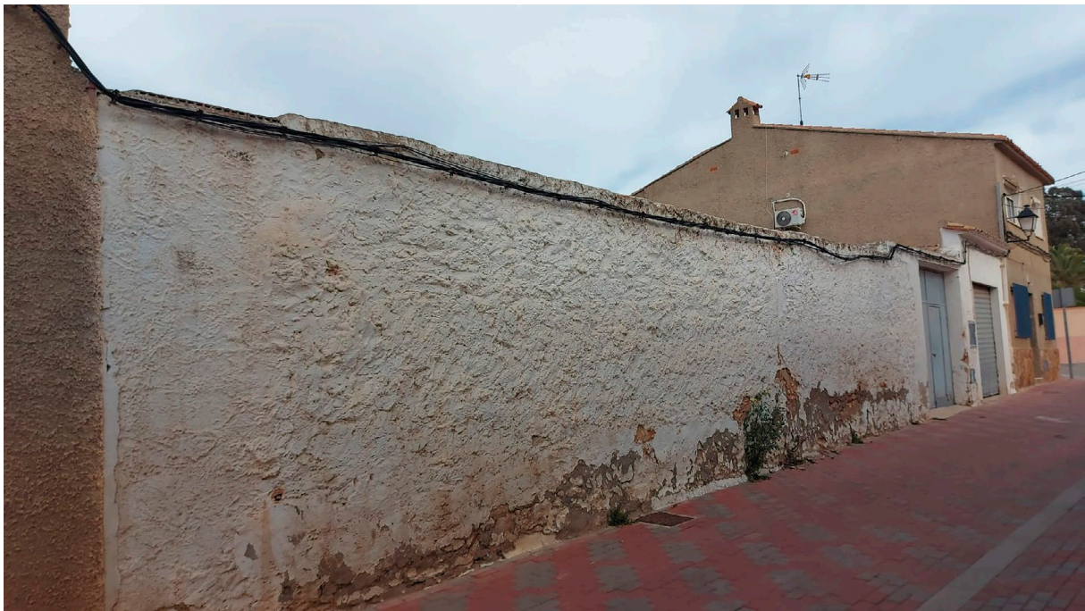
Fig. 16: Corral annex a la casa número 5, avui número 3 del carrer Mare de Déu dels Àngels, [Fotografia], 2024d, Arxiu del CEL.
