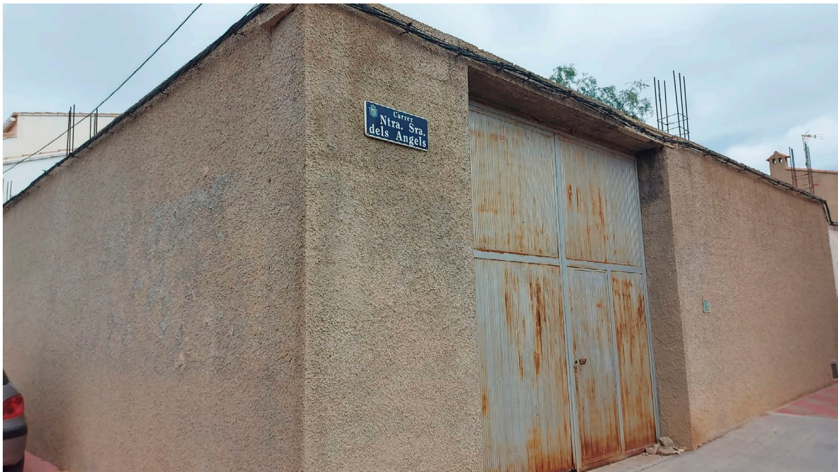
Fig. 15: Aspecte actual de la casa número 5 en el carrer Mare de Déu dels Àngels, 1 ACC, [Fotografia], 2024c, Arxiu del CEL.
